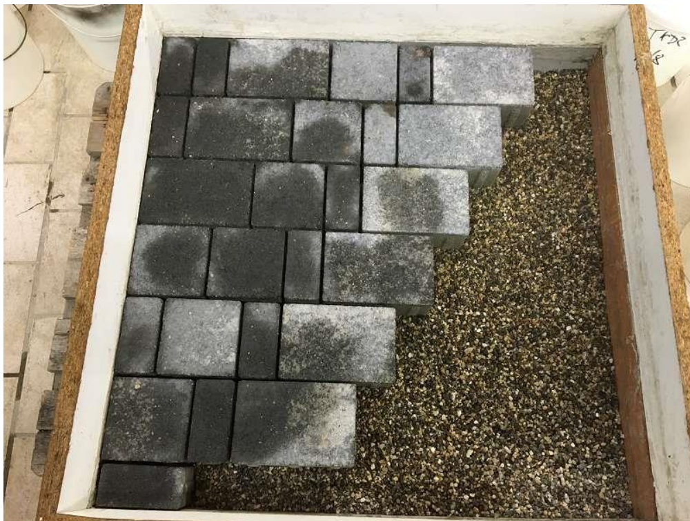
Abbildung 1: Verlegung der Pflastersteine im Hartsteinsplitt 2/5 mm
